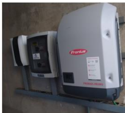
Figura 2: Painéis solares BYD (14 unidades). Figura 3: Inversor Fronius Primo 8,2kW.
